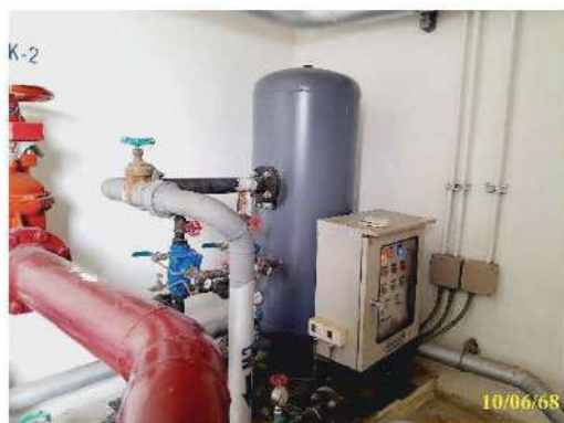
เครื่องปั๊มน้ำ พร้อมถังสำรองน้ำชั้นดาดฟ้า
